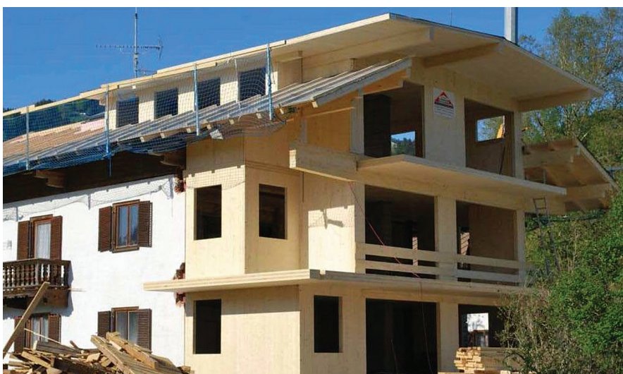
Slika 4. Dogradnja zidanog objekta objektom od CLTa
