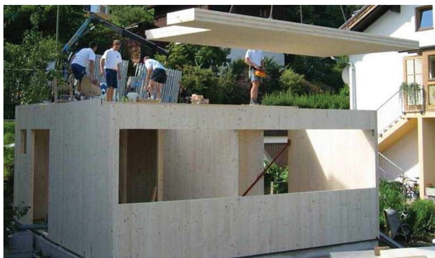
Slika 3. Konstrukcija malog objekta od CLTa
