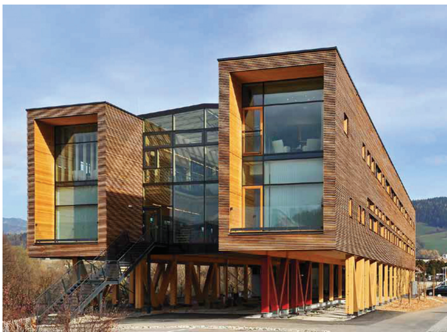
Slika 5. Primer kombinacije tradicionalnih građevinskih materijala i CLTa
