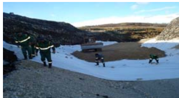
Slika 4. Izgradnja drenažnog sistema za prikupljanje procjednih voda
