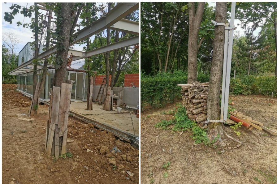
Slika 4. Stabla oštećena prilikom izvođenja građevinskih radova
