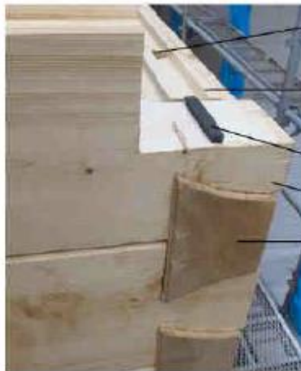
Slika 2 Sistem masivne gradnje podužnim masivnim elementima (talpama) – Blok gradnja
